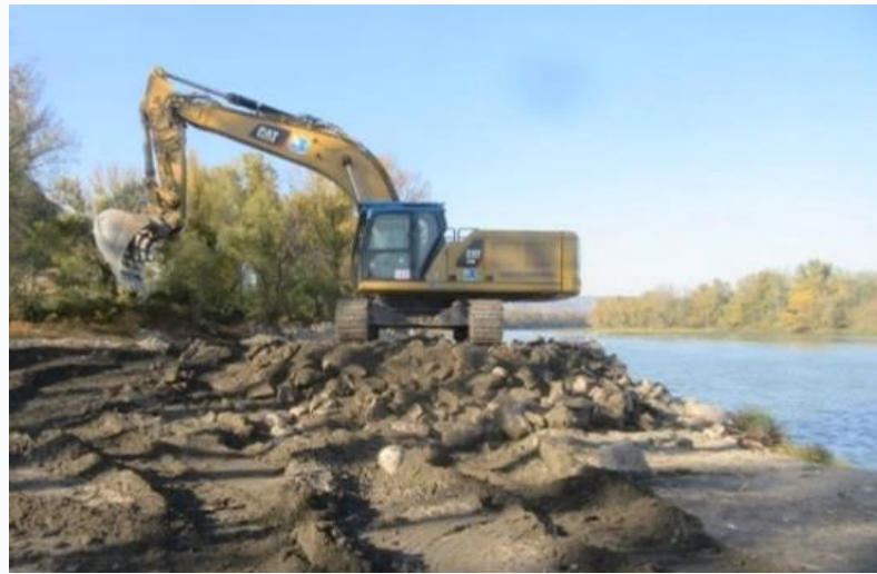
1/ Démantèlement de digues et épis Girardon
