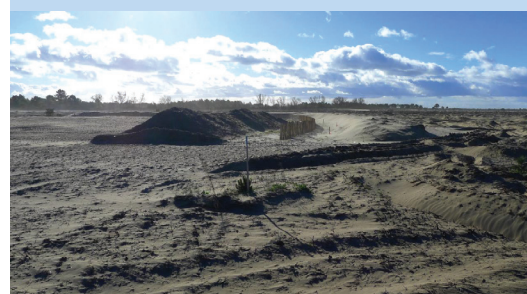
2 Création d'un arc dunaire avec fixation à l'aide d'une ganivelle (clôture en bois)
