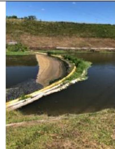
Figure 5 : barrages flottants et absorbants du canal de rejet.
