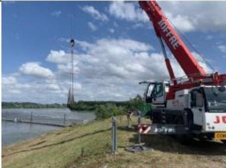
Figure 9 : photographie du levage vers la benne à végétaux lors de l'arrachage des plantes aquatiques dans le canal d'amenée.
