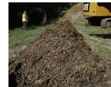
Matériaux grossiers avec rhizomes avant concassage
