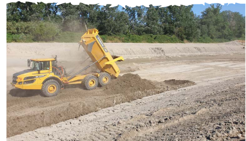
2 Nappage du fond de lône en terre végétale
